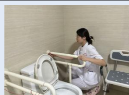
4. 安裝扶手：在浴室等地方安裝扶手
