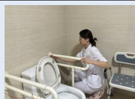
4. 安装扶手：在浴室等地方安装扶手
