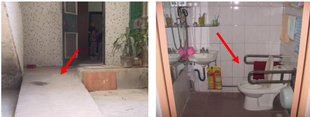
圖 4：門口臺階改成斜坡、衛生間安裝帶扶手的坐廁
