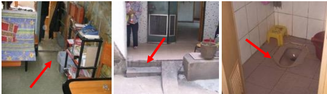
圖 3：房間入口阻塞、臺階、蹲廁
